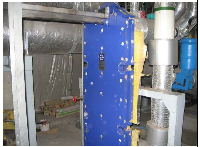
写真8 フレーム整備後
