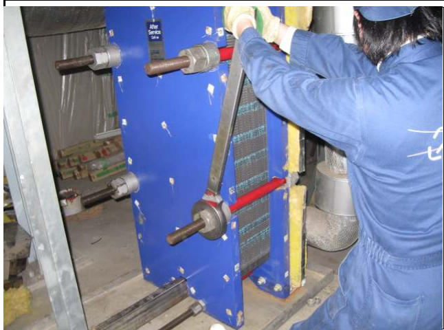
写真21 プレート締付中
