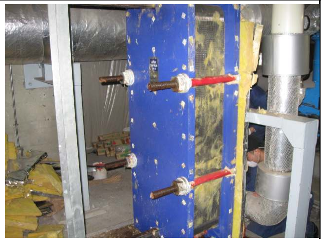
写真2 ラッキング保温材取外し
