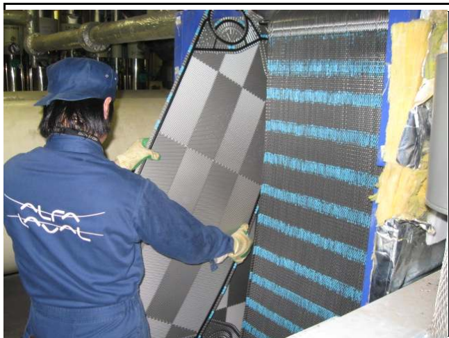
写真19 プレート組込中
